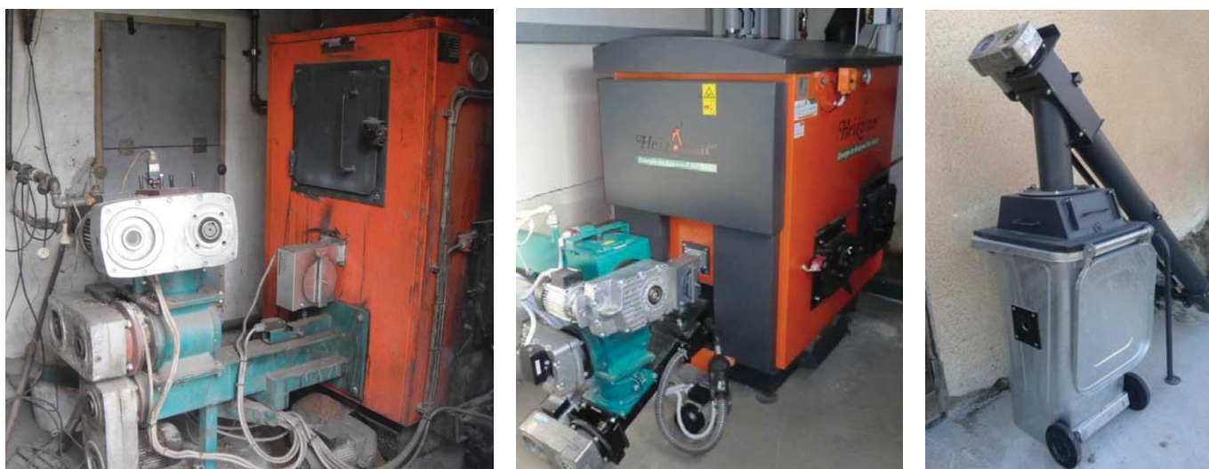
Figura 2 – Aspetto della centrale termica prima e dopo il risanamento, con il nuovo contenitore per la cenere.
