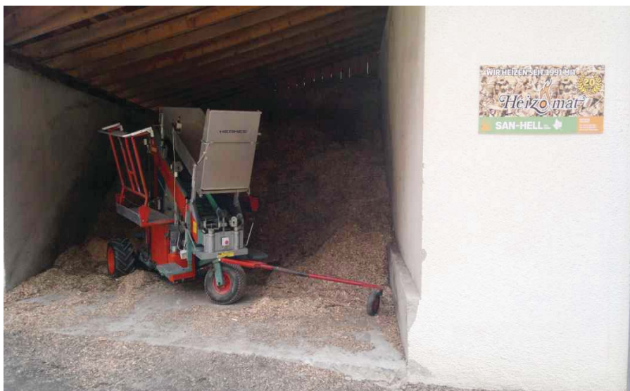
Figura 2 – Silo del cippato, il consumo stimato è di 40 t/anno M30.
